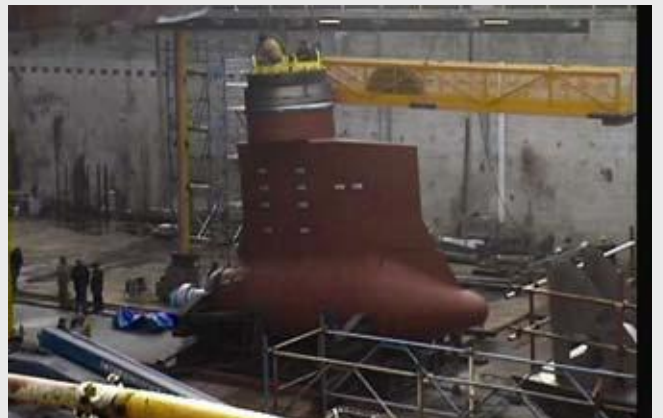
Rudersektion eines Schiffes im Trockendock, 200 Tonnen.
